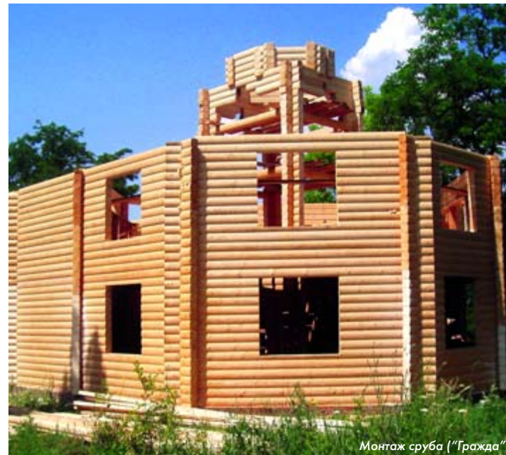
Монтаж сруба ("Гражда")
