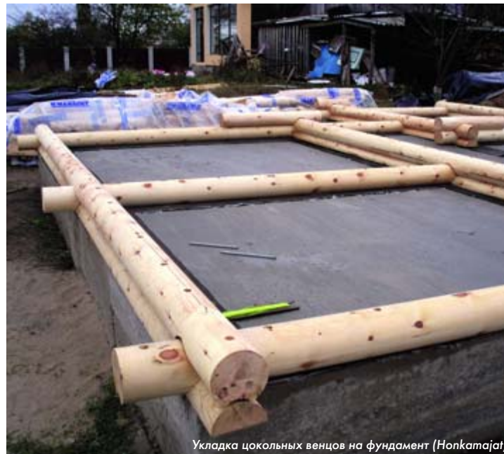
Укладка цокольных венцов на фундамент (Honkamajal)
